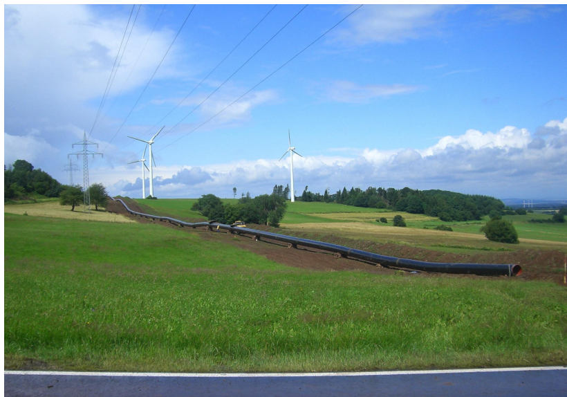
Foto: RP, Bau der eon-Gasleitung durch Mittelhessen
